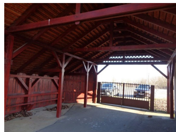
a meglévő épületről készített állapotfelmérési fotók
